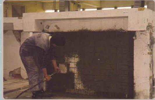
Zenon Panellerin sıvanması
