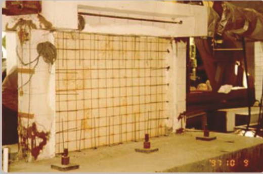
Zenon Panellerin çerçeveye montajı
