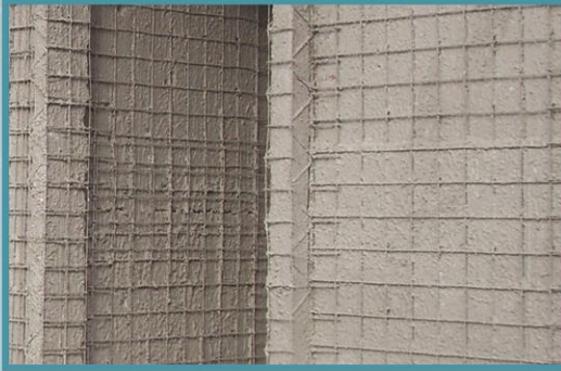
İlk kat serpmeye sıva ile hasır teline kadar harç doldurulur.
