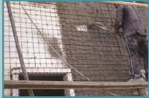
Püskürtme sıva makinesi ile sıva tatbik edilişi
