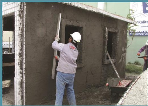
İlk kat serpmeye sıva ile hasır teline kadar harç doldurulur.
