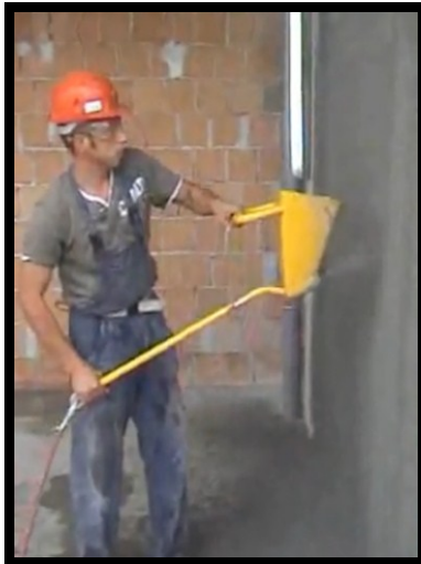
Harcın duvara püskürtülmesi
